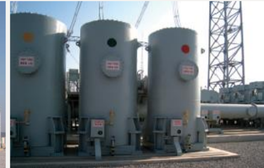
1000kV AC arrester
