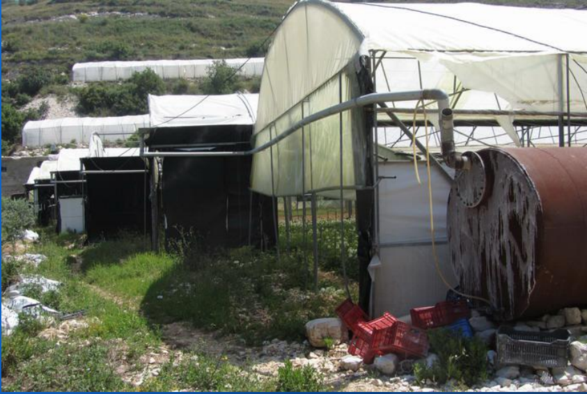
حصاد مياه الأمطار من أسطح البيوت البلاستيكية وتجميعه في خزانات (لبنان)
