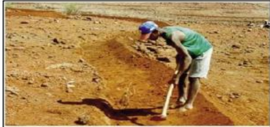
عملية بناء ثلثات ترابية لتجميع مياه الأمطار
