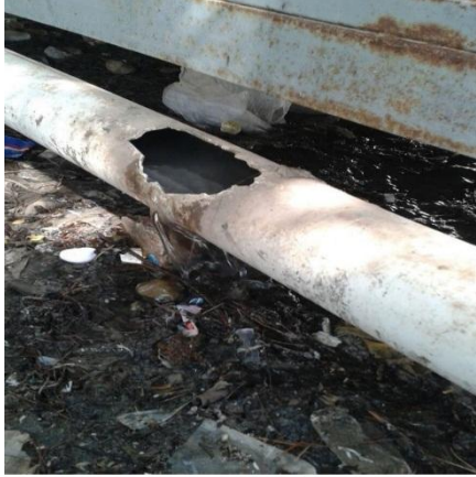
محافظة اللاذقية/ المدينة الرياضية/مركز ابواء النازحين/صرف صحي
